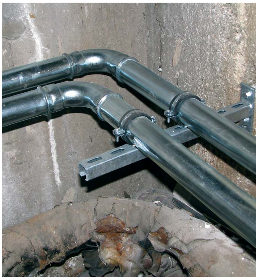
Rys. 3. System KAN-therm Steel bardzo dobrze sprawdza się podczas remontów i wymiany starych instalacji grzewczych
