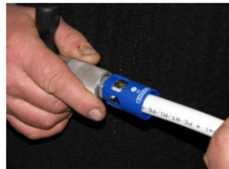
Proces kalibracji rury wielowarstwowej
