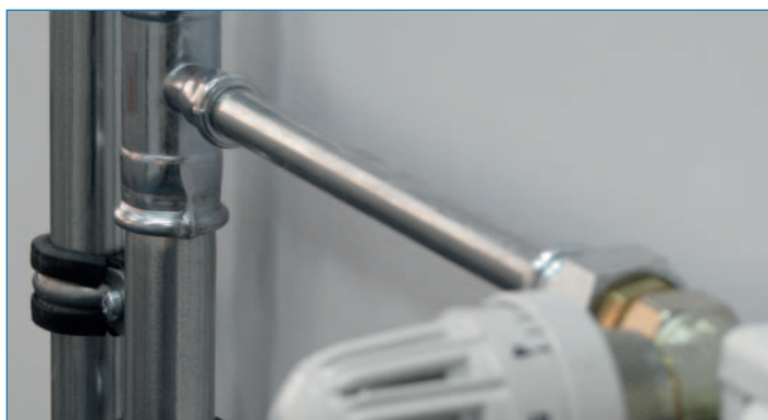
rys. Podłączenie grzejnika (gałązka zasilająca i powrotna) w Systemie KAN-therm Steel
