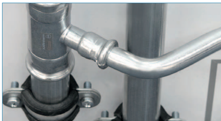
rys. Podłączenie grzejnika (gałązka zasilająca i powrotna) w Systemie KAN-therm Steel
