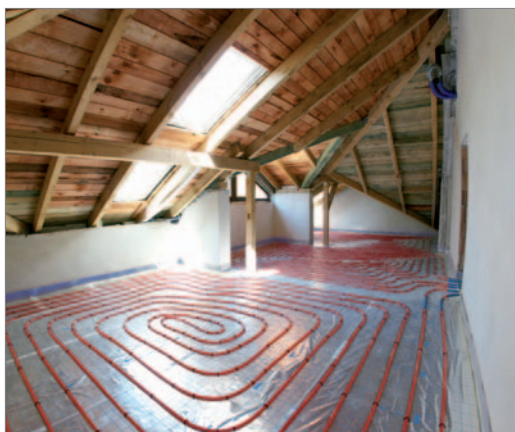
Ogrzewanie podłogowe układane metodą moką – rury grzejne zalane jastrychem
