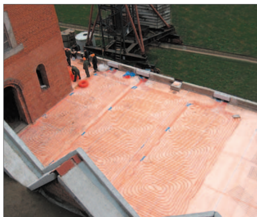
Ogrzewanie podłogowe układane metodą moką – rury grzejne zalane jastrychem
