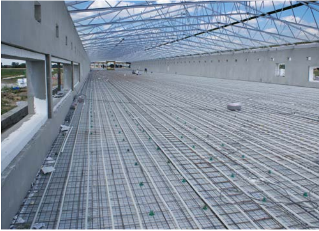
Instalacja KAN-therm ogrzewania hali kurnika (2500 m 2 ) hodowli ściółkowej - Brzozowo Wielkie.
