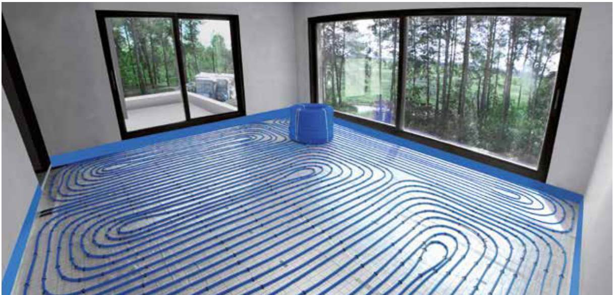
Rys. 3. Instalacja ogrzewania podłogowego w domu jednorodzinnym, przy wykorzystaniu rur bluePERT i systemu KAN-therm Tacker.
