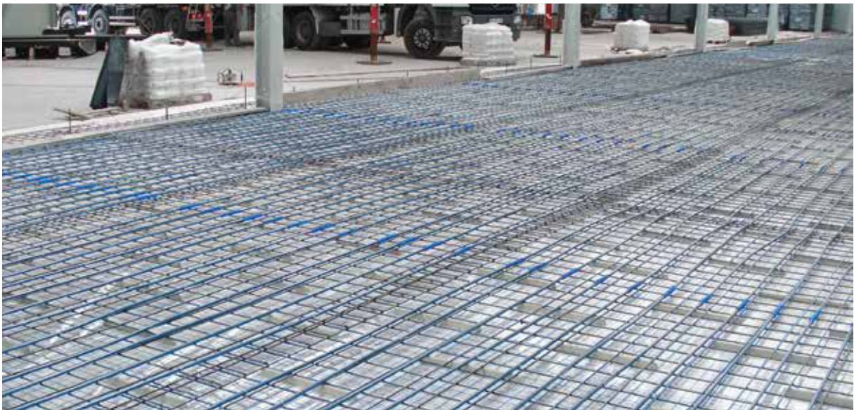
Rys. 4. Instalacja ogrzewania podłogowego w hali magazynowej, przy wykorzystaniu rur bluePERT i systemu KAN-therm NET.
