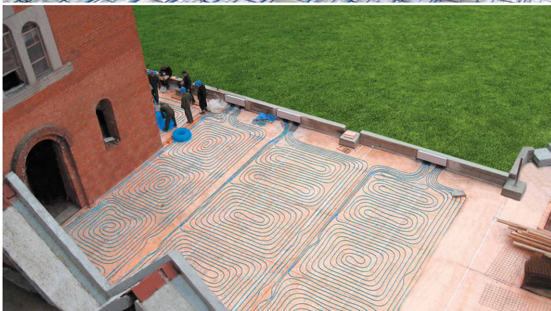
Rys. 5. Instalacja podgrzewania zewnętrznego tarasu przy wykorzystaniu rur BlueFloor PERT systemu KAN-therm.
