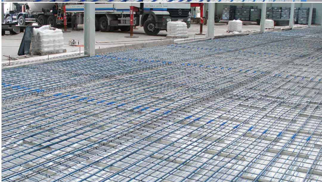
Rys. 4. Instalacja ogrzewania podłogowego w hali magazynowej, przy wykorzystaniu rur BlueFloor PERT i systemu KAN-therm NET.
