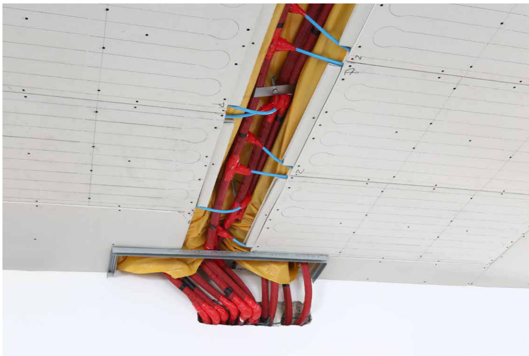
Rys. 6. Instalacja chłodzenia sufitowego z wykorzystaniem płyt grzewczo-chłodzących systemu KAN-therm Wall.
