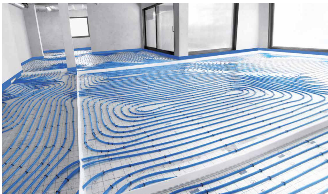
Rys. 25. Instalacja ogrzewania/chłodzenia podłogowego wykonana w systemie KAN-therm Tacker.
